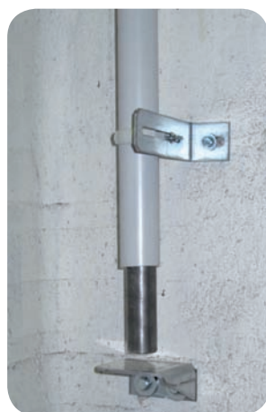
B Fixation du cordon et du poids
