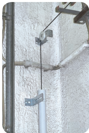
A Fixation de la poulie de renvoi à l'équerre
