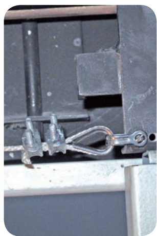
C Fixation du cordon au chariot de la porte palière
