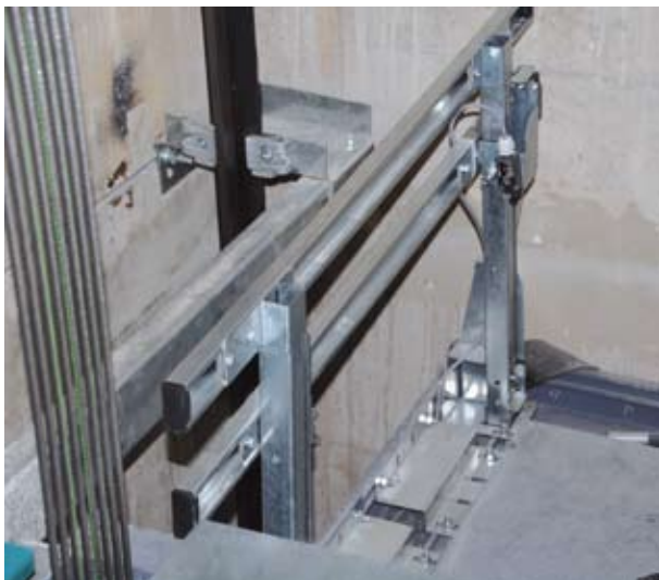
Exemple de montage garde-corps entré
