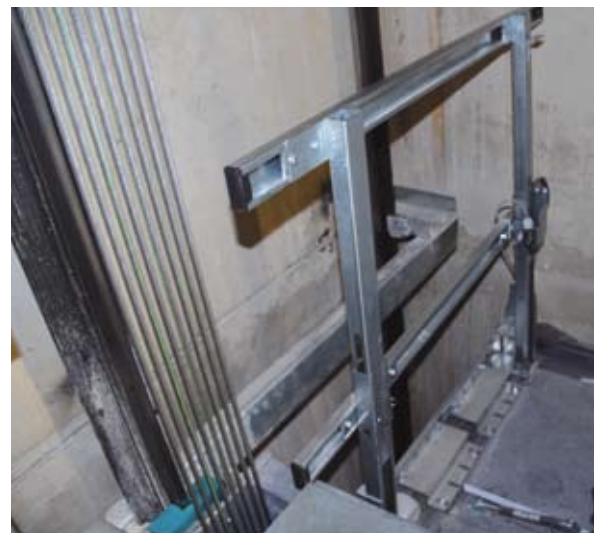
Exemple de montage garde-corps sorti
