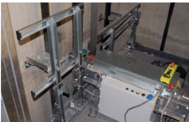
Exemple de montage pour garde-corps pliable et télescopique
