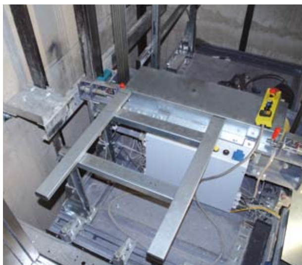
Exemple de montage garde-corps entré
